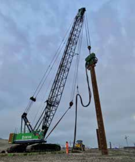
Om buispalen van 35 ton de Deense klei in te heien, mag je wel bijzonders iets meebrengen.
